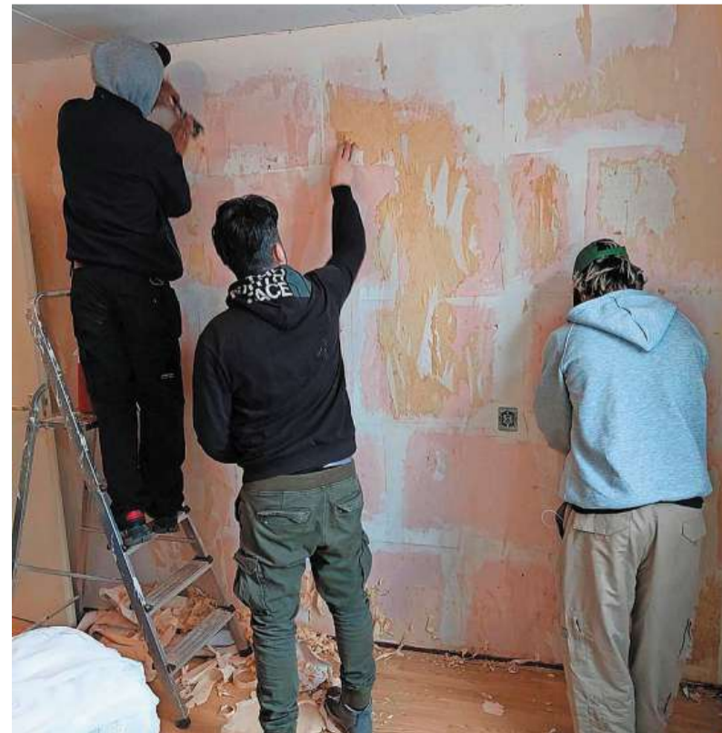
Gaten in de muren worden gestopt en daarna geveerd.
